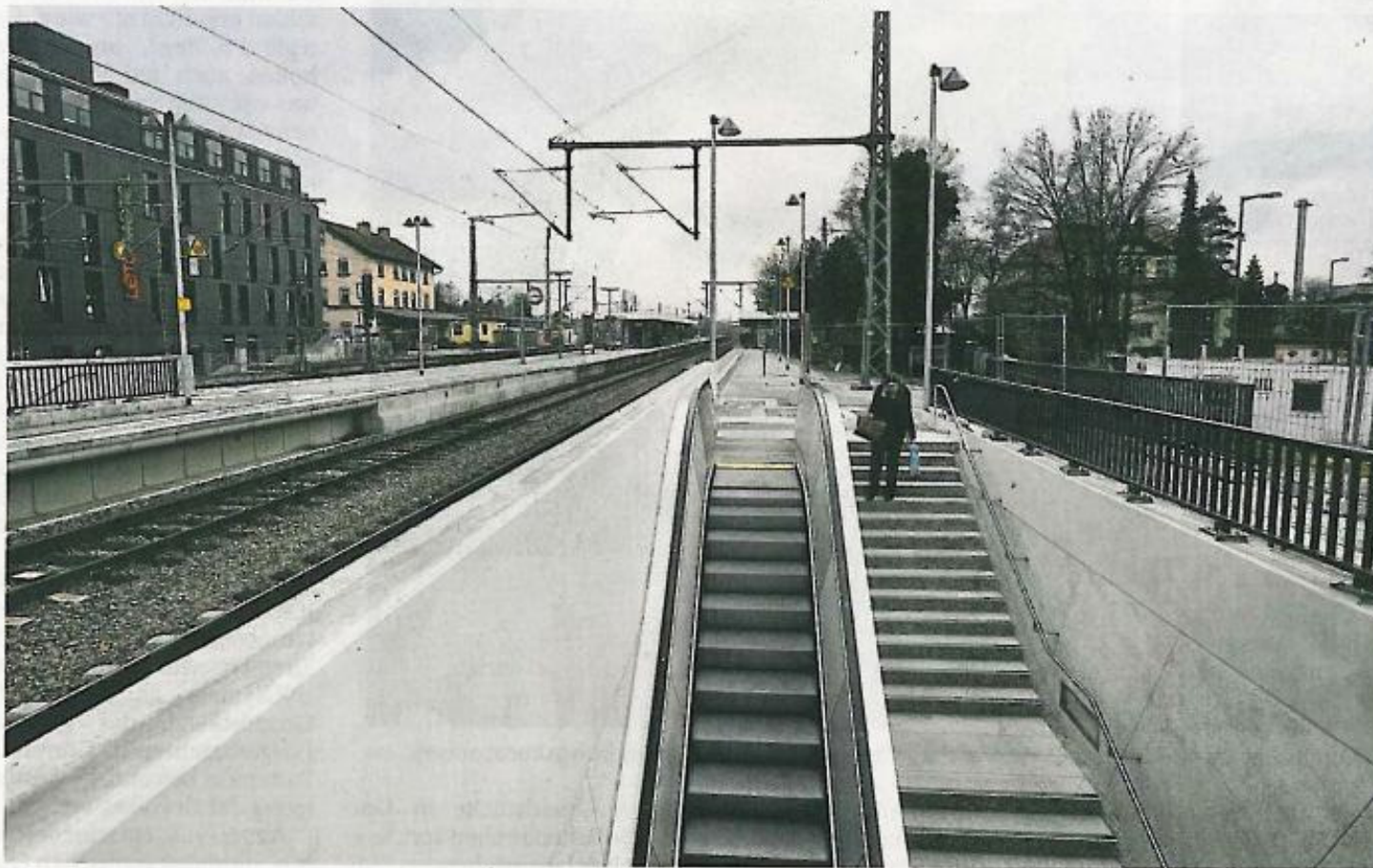
Nicht überdachte Treppen und einen zu langen Weg von der S-Bahn bis zum U-Bahn-Zugang kritisiert „Pro Bahn“.
